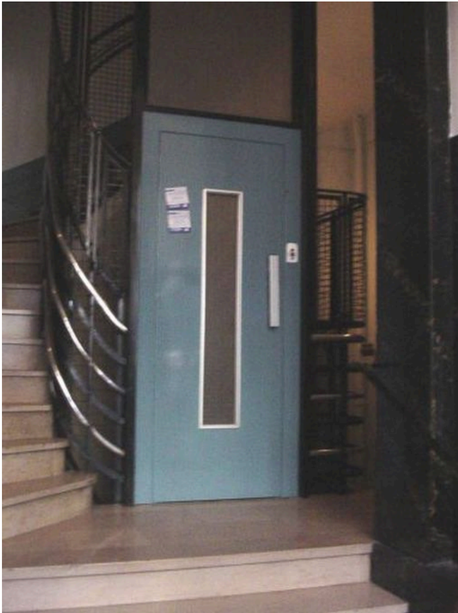
Ascenseur et départ d'escalier
