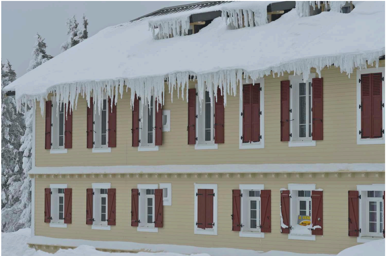
Façade arrière, détail sous la neige.
