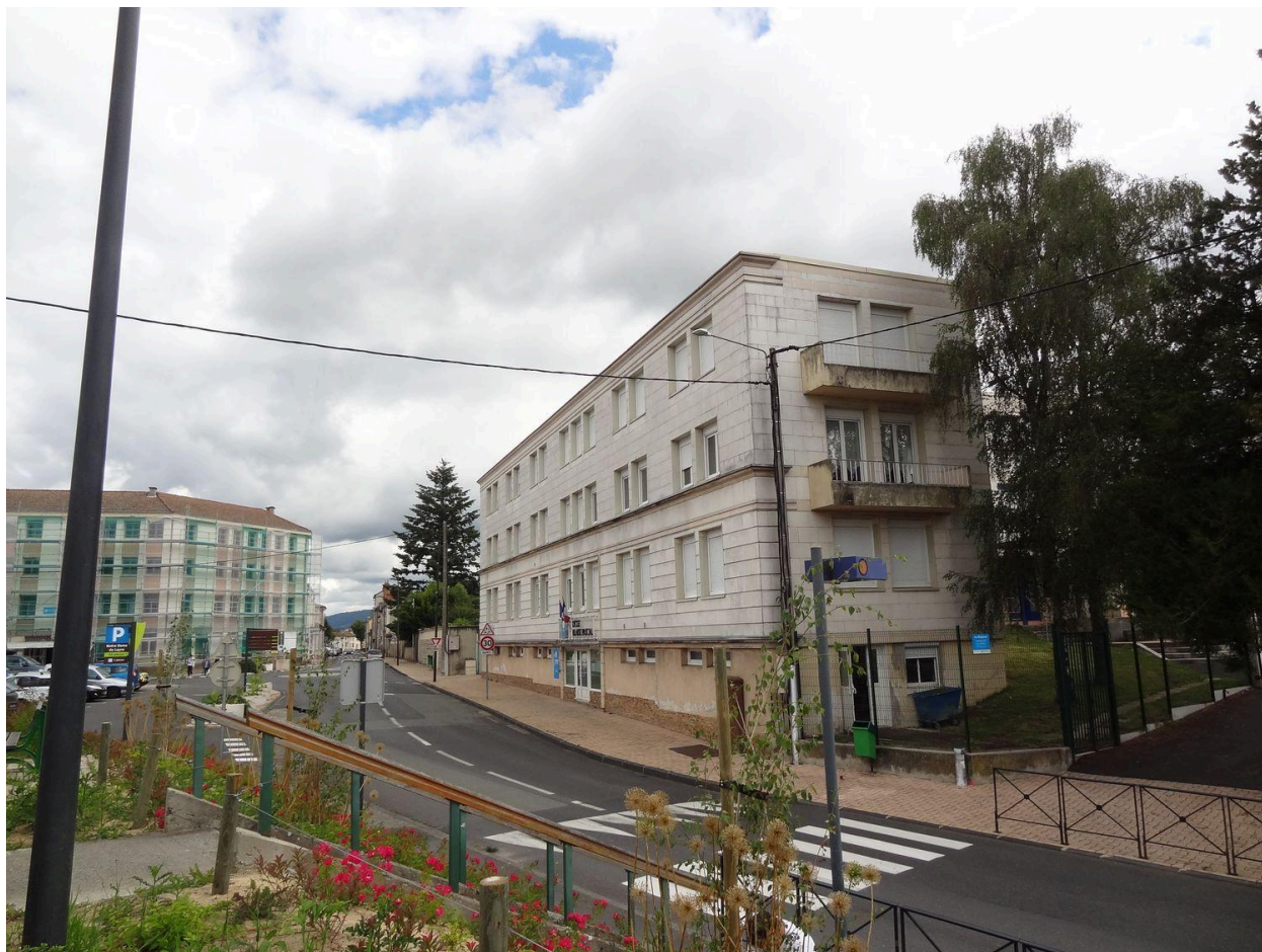
Vue sur le bâtiment du lycée aligné sur la rue Blaise-Pascal. A gauche, la cité administrative (à l'emplacement de l'ancienne prison) en travaux.
