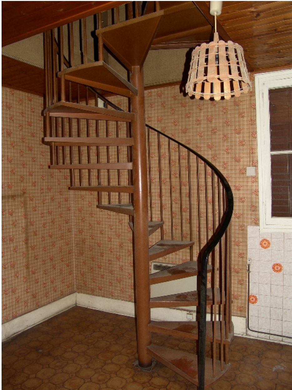
Garage de réparations automobiles : escalier du logement
