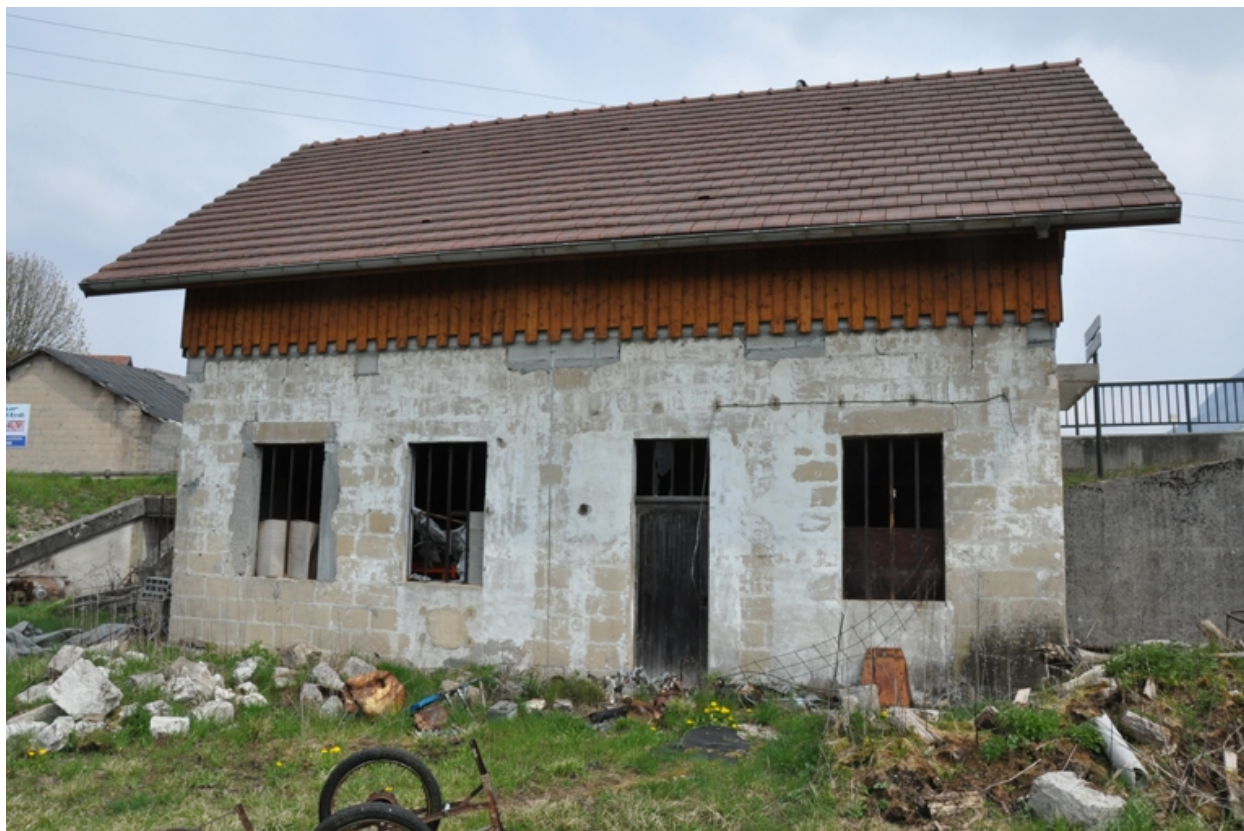
Vue de la façade ouest
