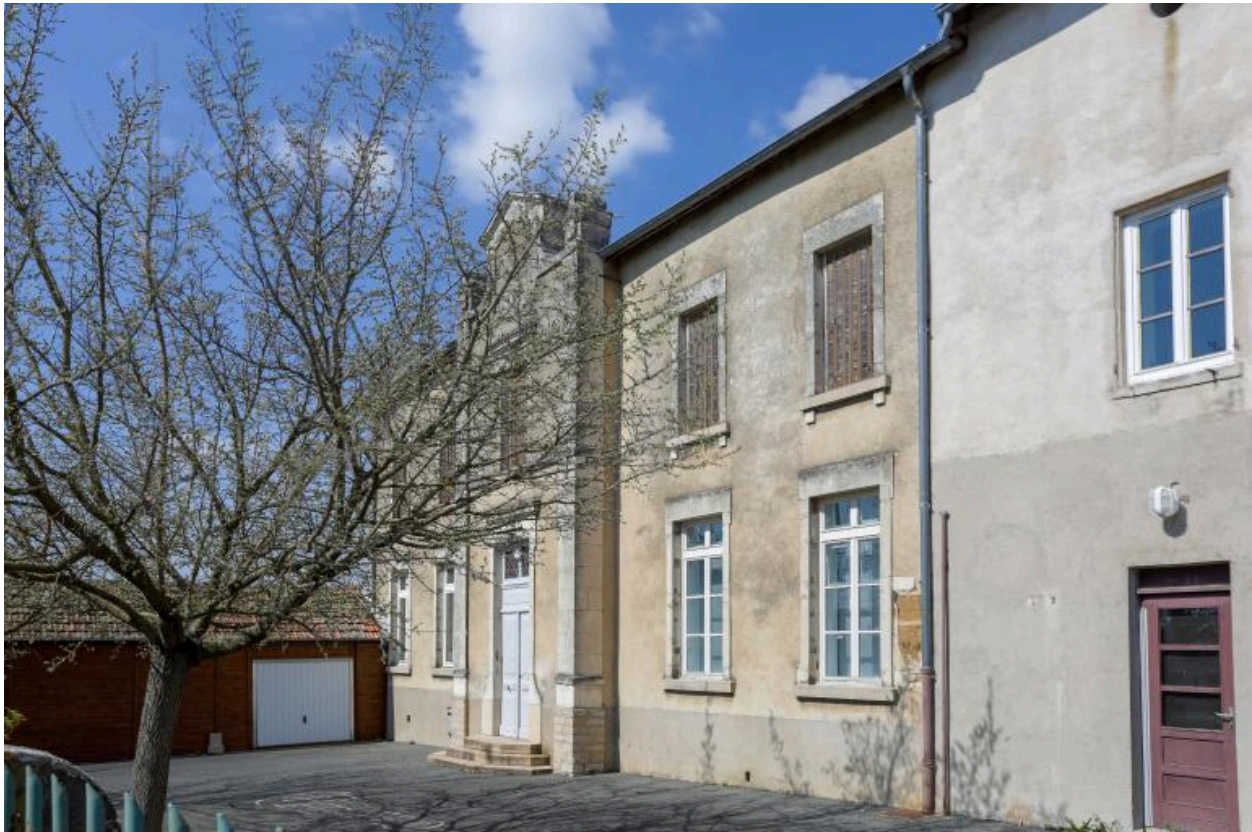
Façade de l'école.
