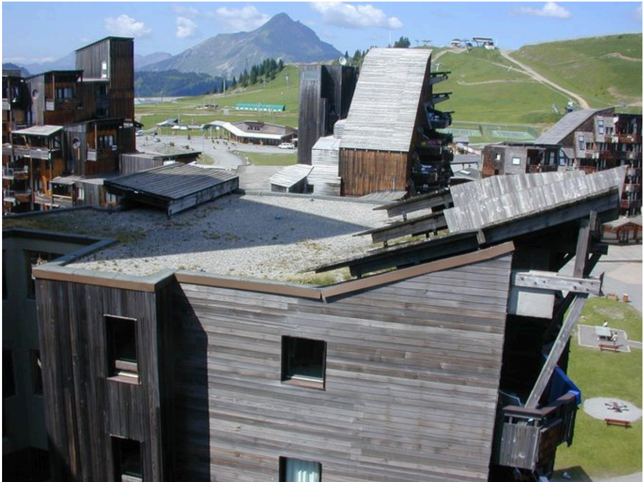
Le pignon sud, vue des toits
