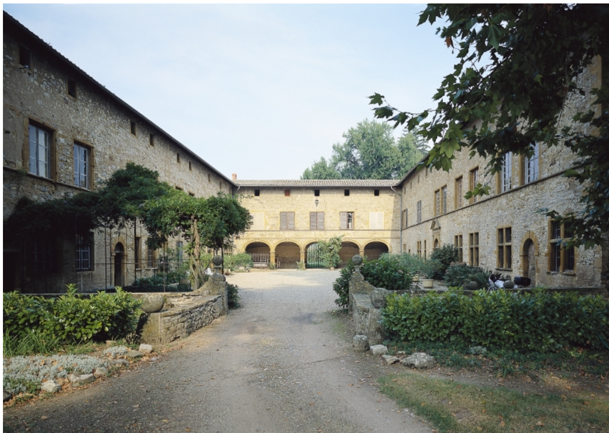
Vue d'ensemble du bâtiment, sur cour.
