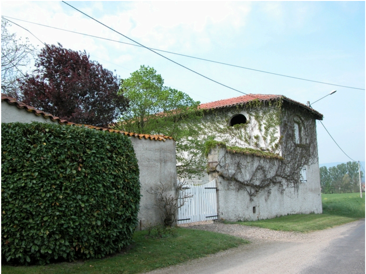
Vue du bâtiment ouest depuis le chemin.
