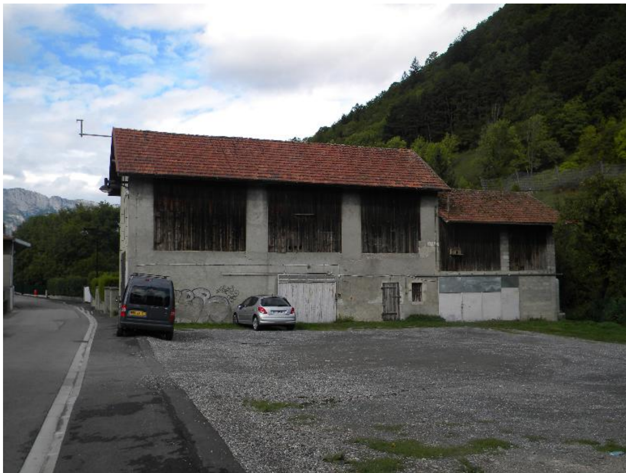
Vue d'une ancienne grange à l'entrée ouest du village (2008 C6 896)
