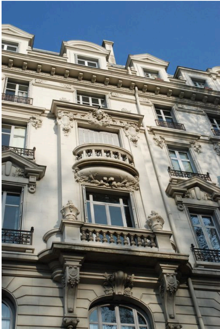
Vue d'une travée extérieure, traitée en saillie avec balcons en pierre
