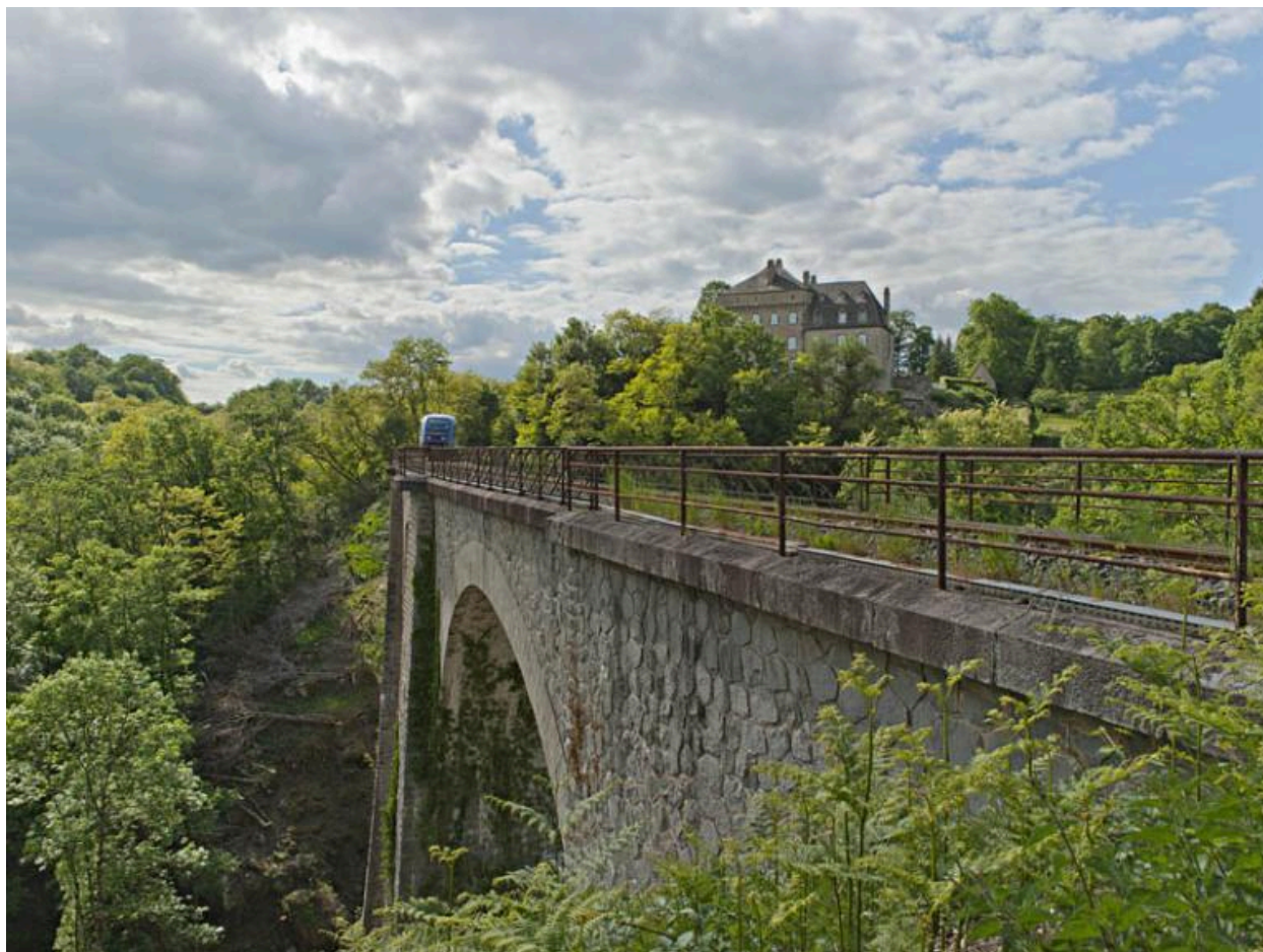
Vue du viaduc ferroviaire de Viescamp, côté aval, au sud.
