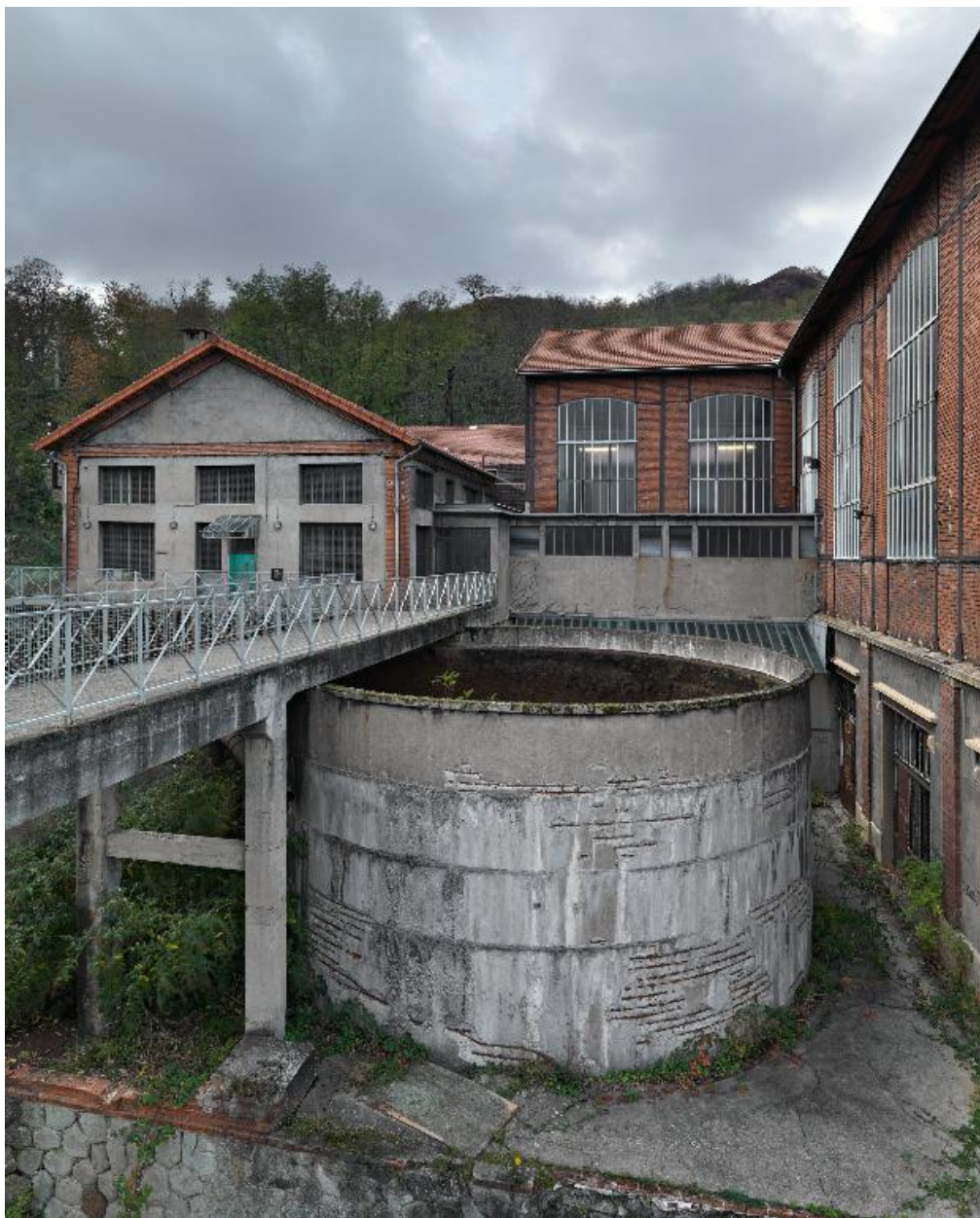
Bassin de stockage des eaux d'exhaure
