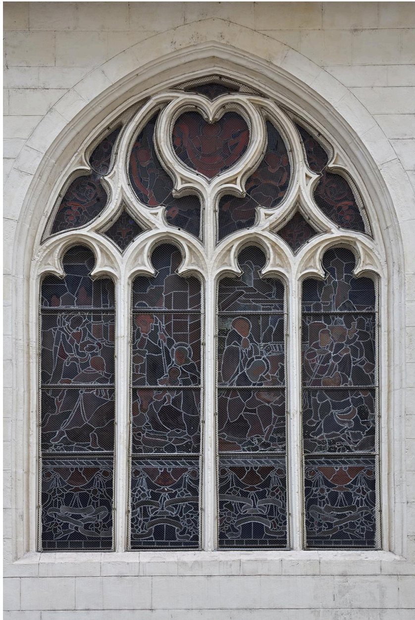
Elévation ouest, baie 6
