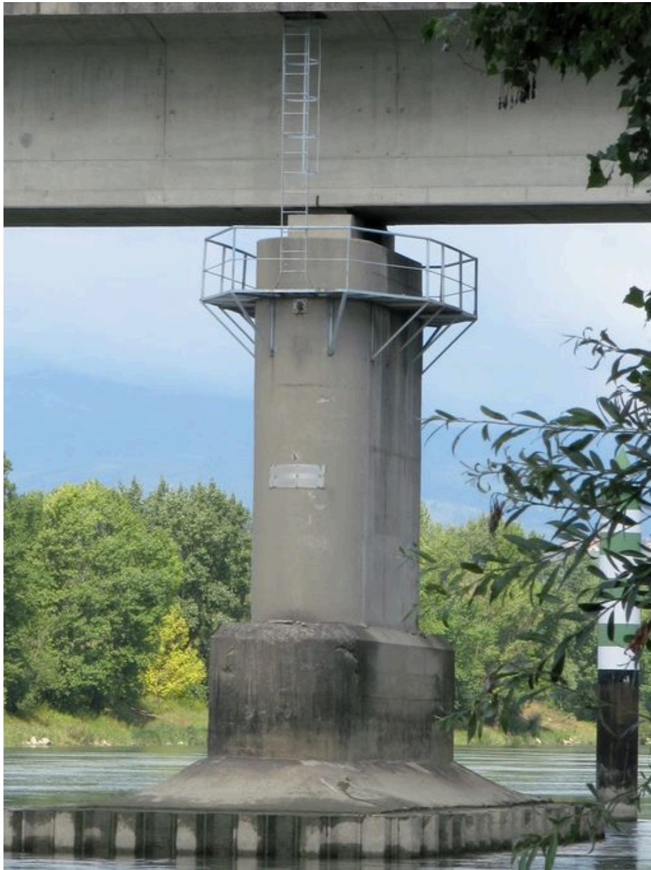
Pile, face aval (depuis la rive gauche)
