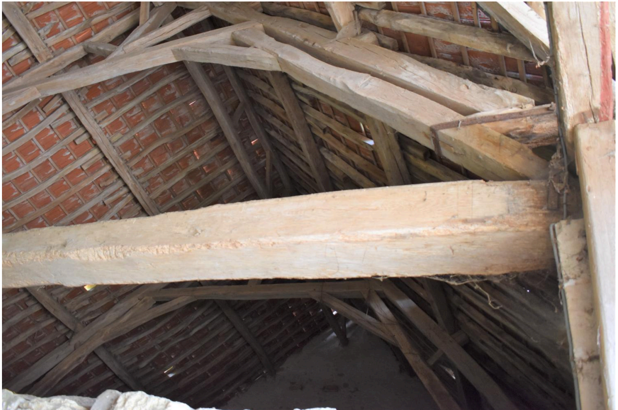
Détail de la charpente au nord de la grange à auvent.
