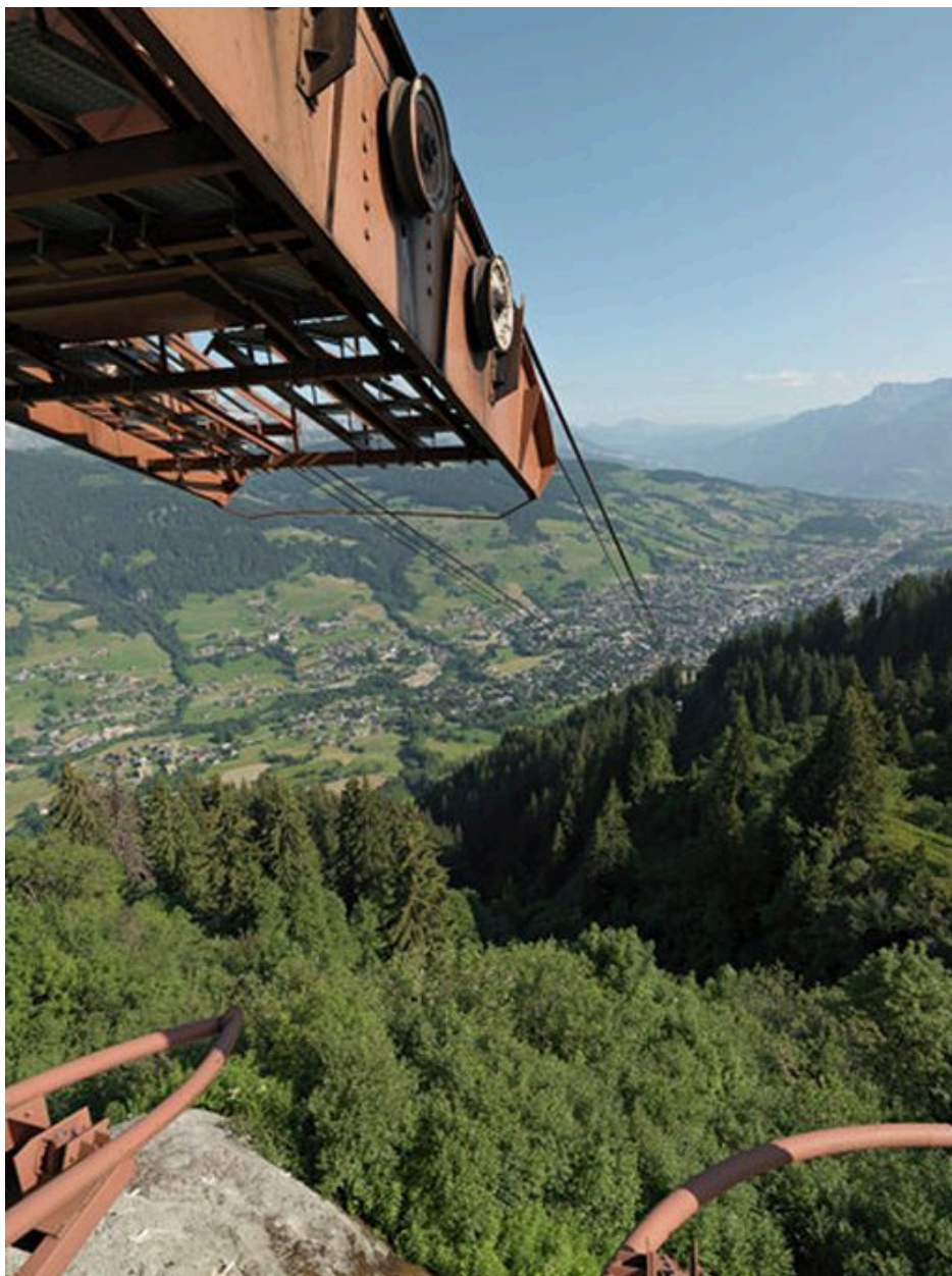
La passerelle de lancement de la gare supérieure
