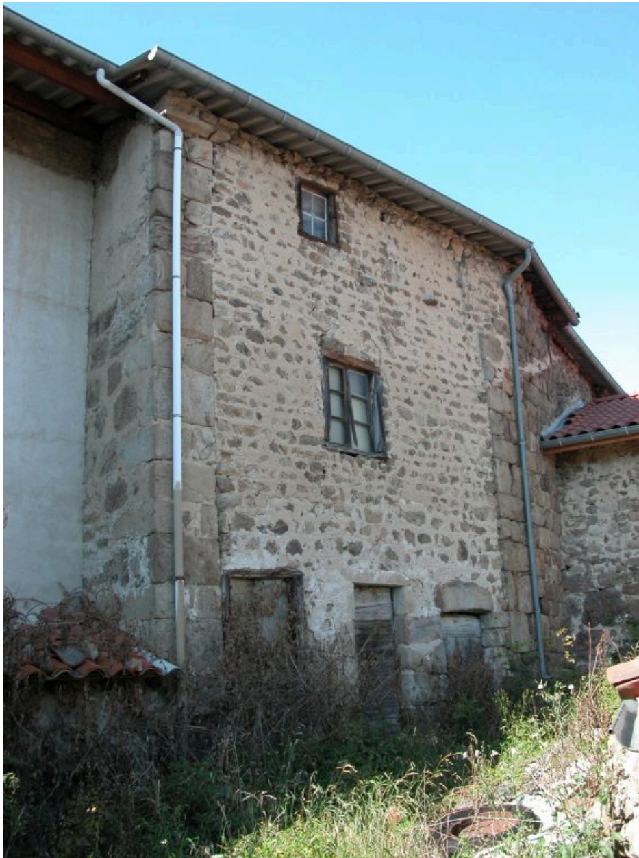
Elévation du logis 2 et entrée de l'étable nord-ouest, depuis le sud-est.
