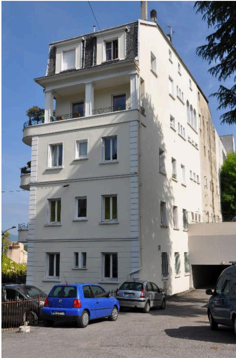
Façade latérale droite (façade sud) et façade postérieure (façade est)
