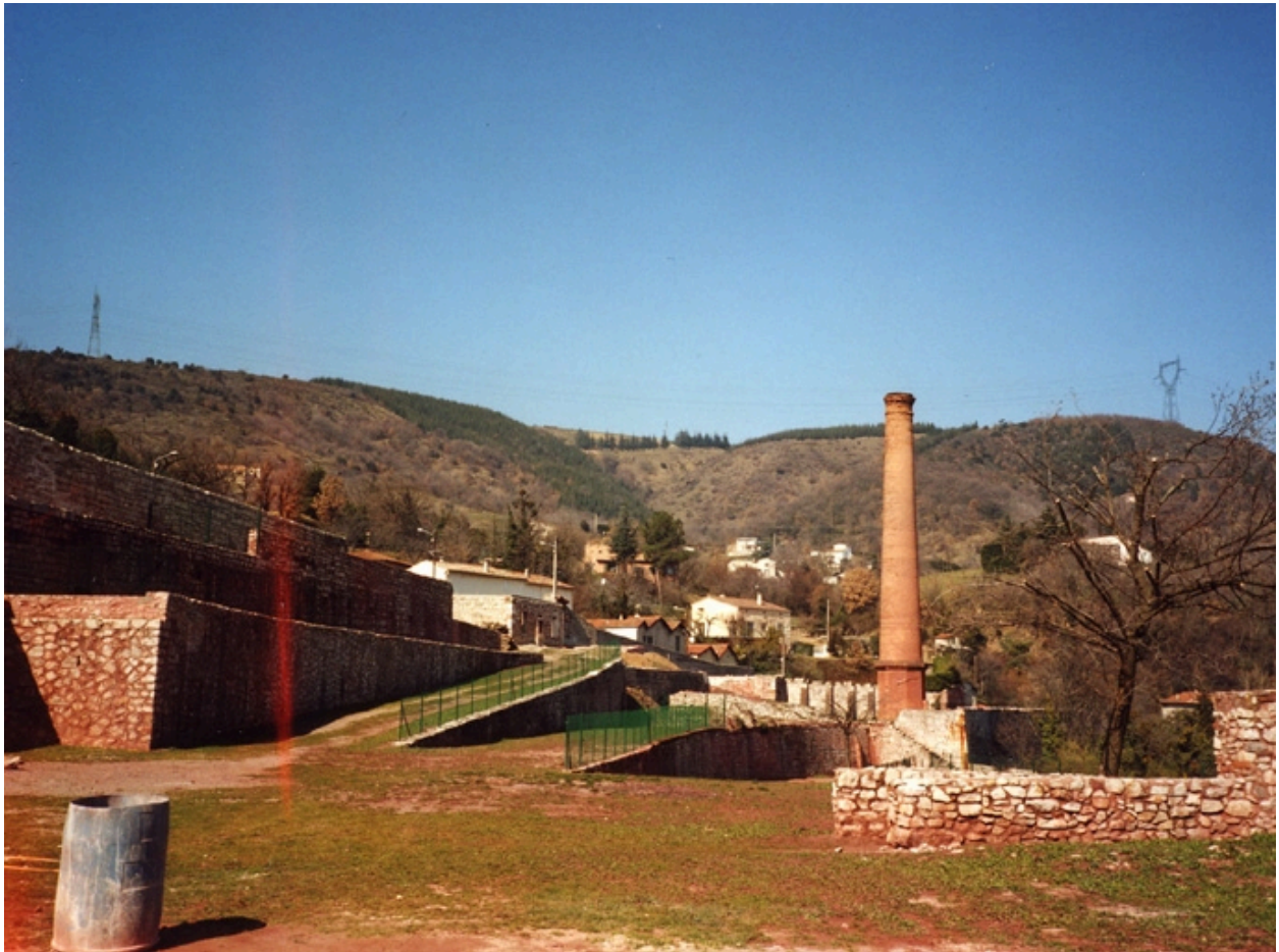
Cheminée vue sud-est, rampes
