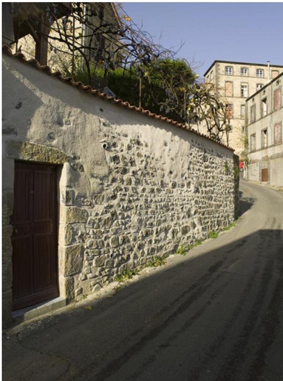
La rue au niveau du jardin suspendu du n° 21.
