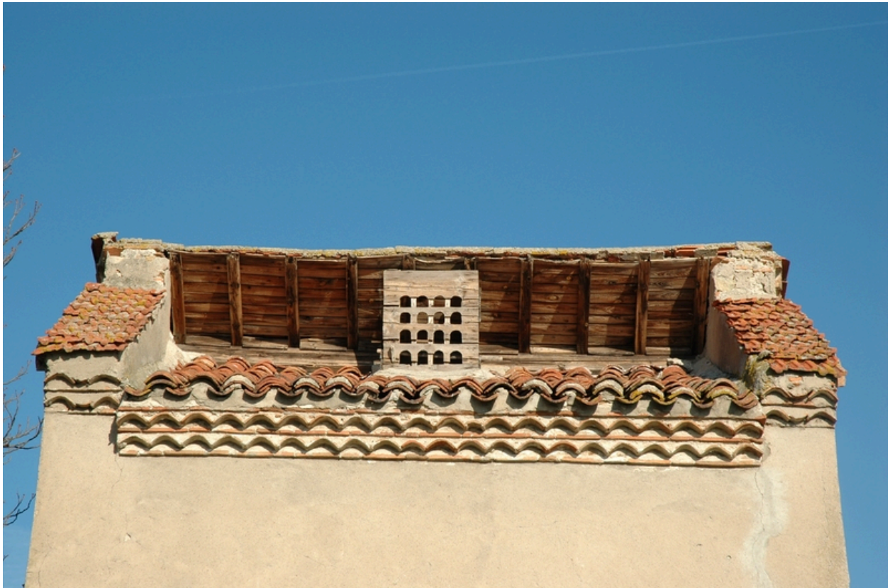
Détail du toit-chauffoir.
