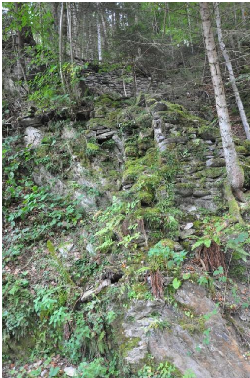
Vestiges des moulins vus depuis le chemin en contrebas.
