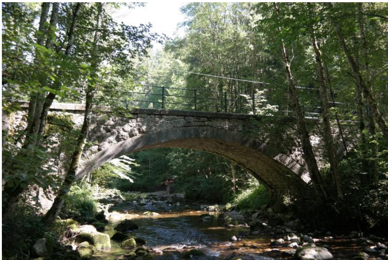
Vue générale du pont de la Cascade
