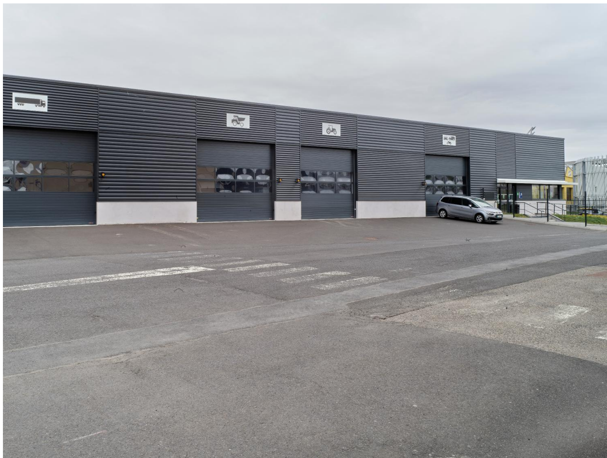
Élévation ouest du bâtiment G37, sur la rue de la Cataroux.
