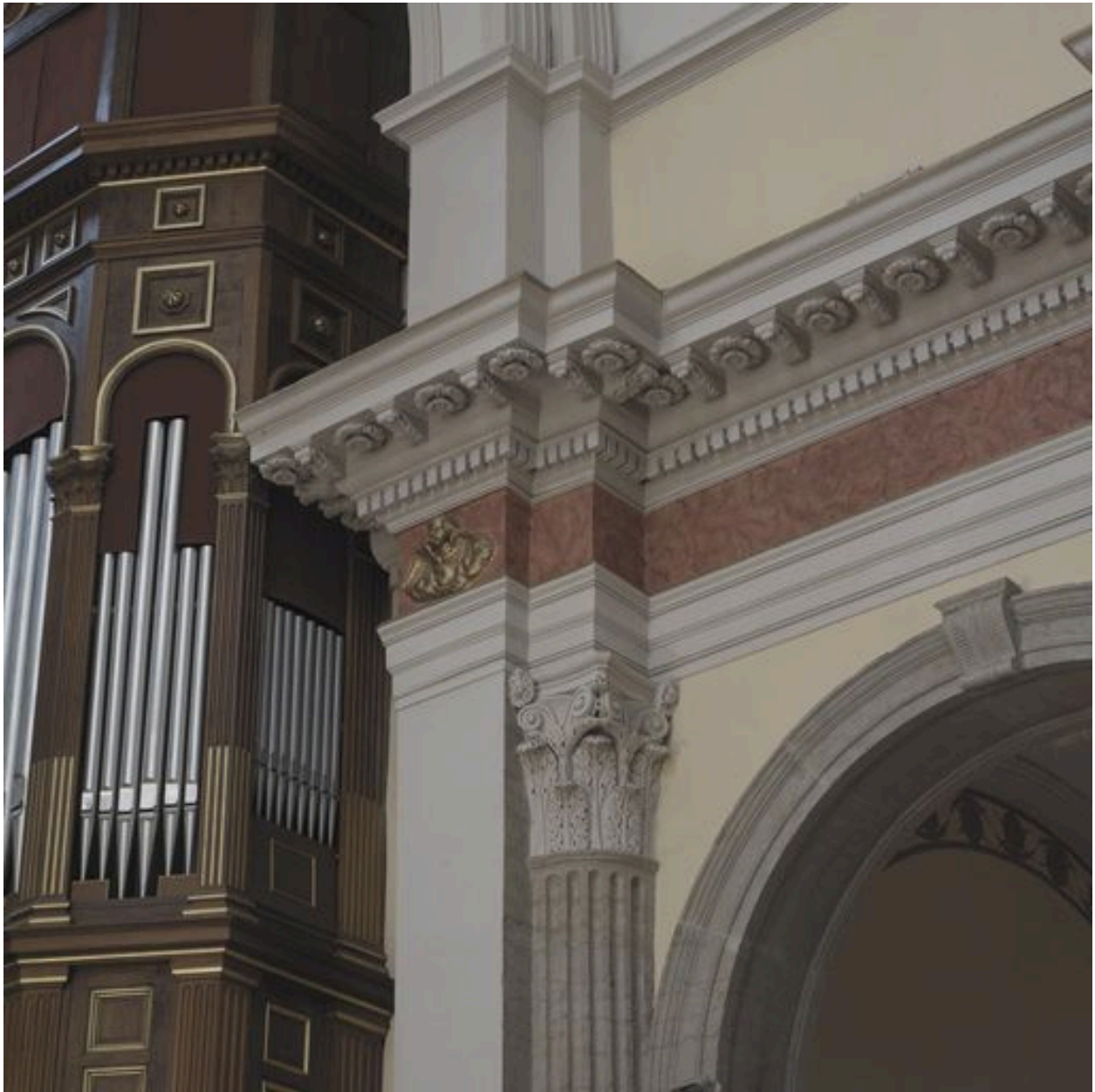
Chapiteau de l'entrée du choeur
