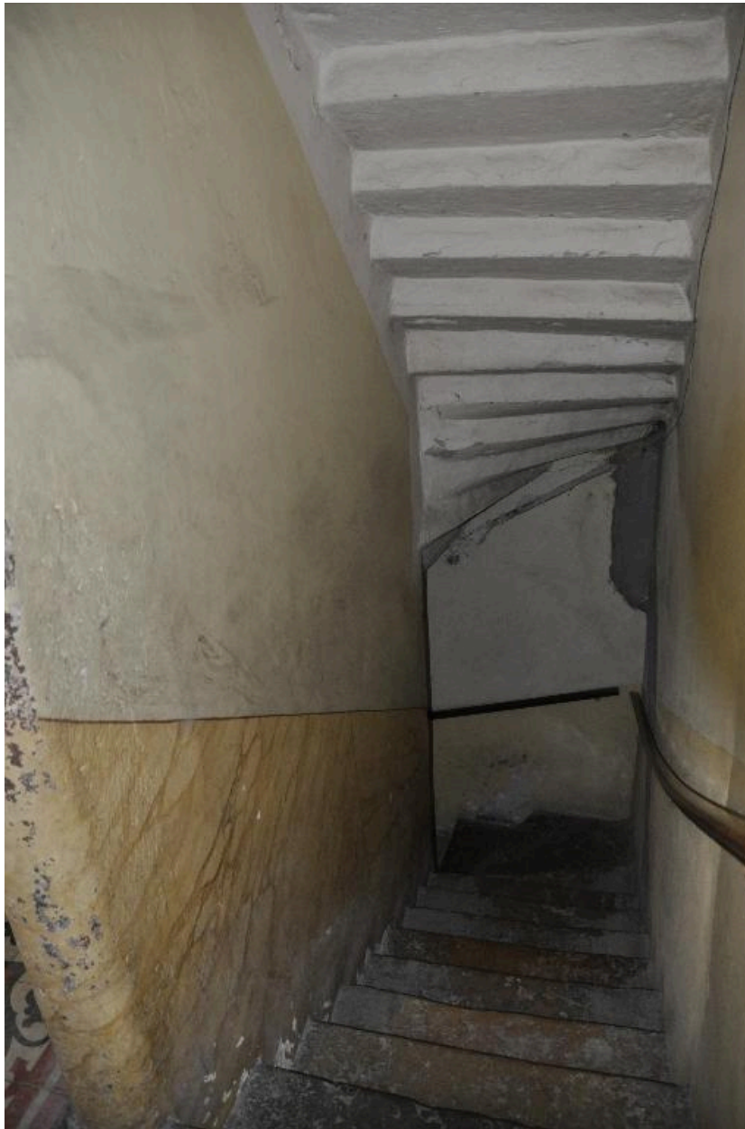
Vue de l'escalier depuis le palier
