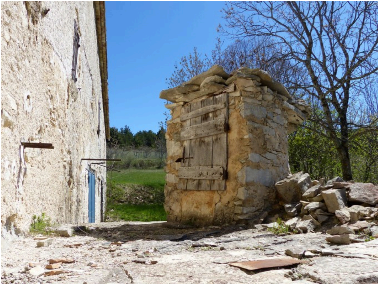
Puits de la citerne, vue de trois-quart.
