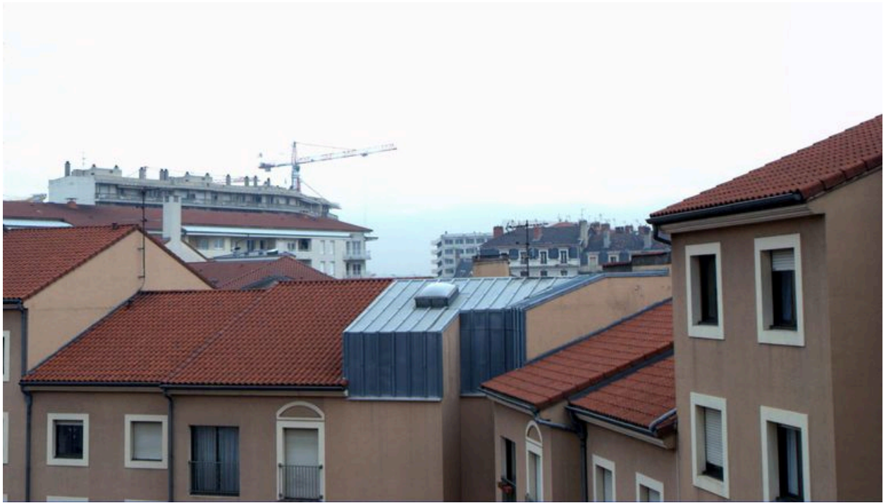
Détail des toitures depuis l'ouest
