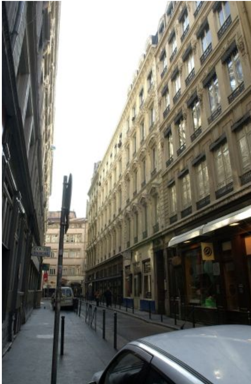
Façade rue Longue, vue générale
