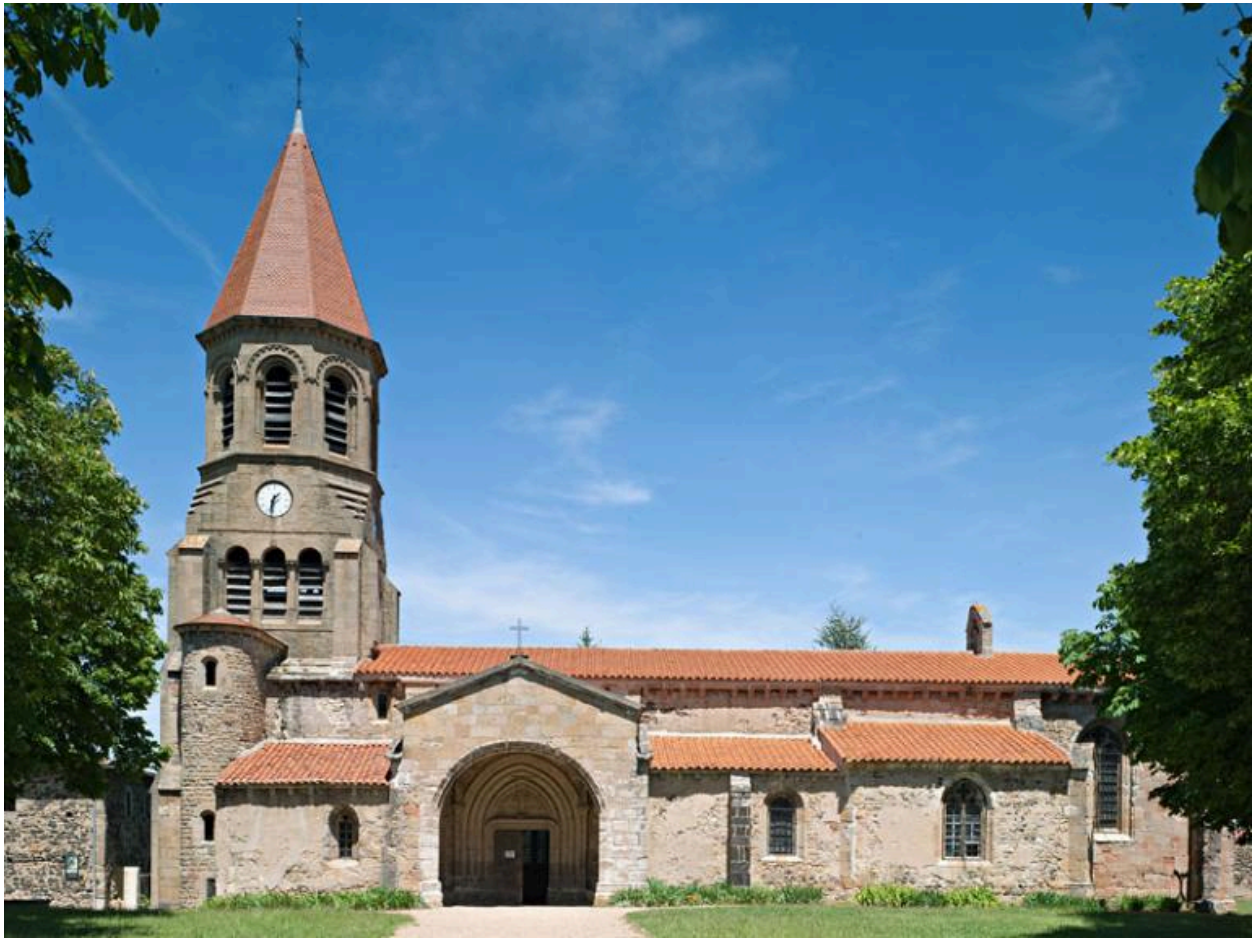
Vue générale de la façade méridionale.
