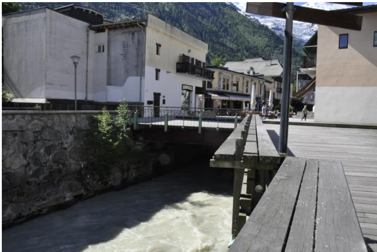
Vue de la face aval de l'ensemble des ponts
