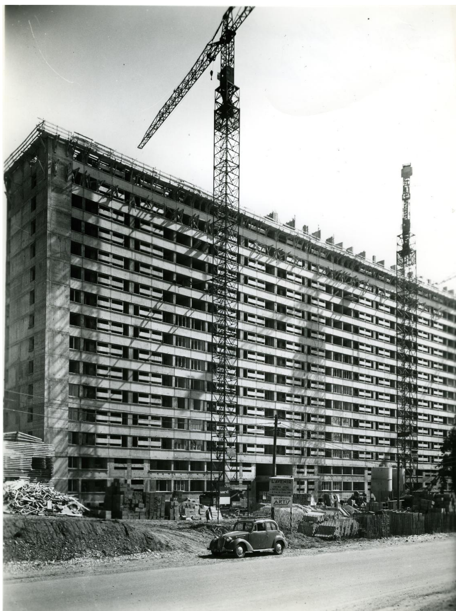
Construction de la barre de la SACVL à Balmont, 1962 (archives de l'Avenir)
