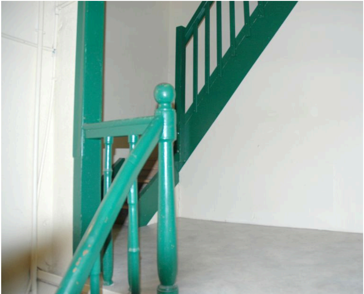
Garde-corps d'une rampe d'escalier à barreaux simples et barreaux en bois tourné, 2 rue Puy du Roseil.
