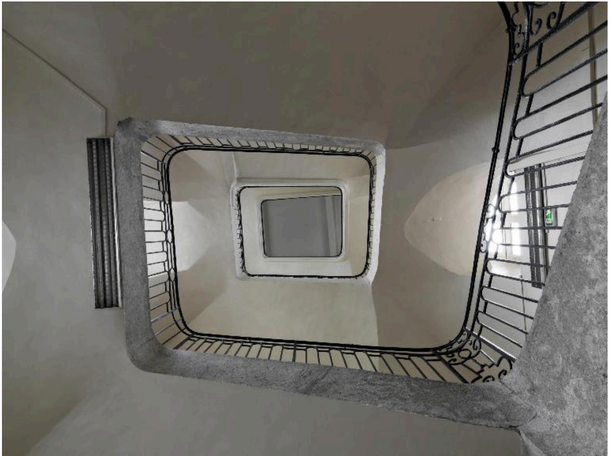
Cage de l'escalier principal, depuis le bas
