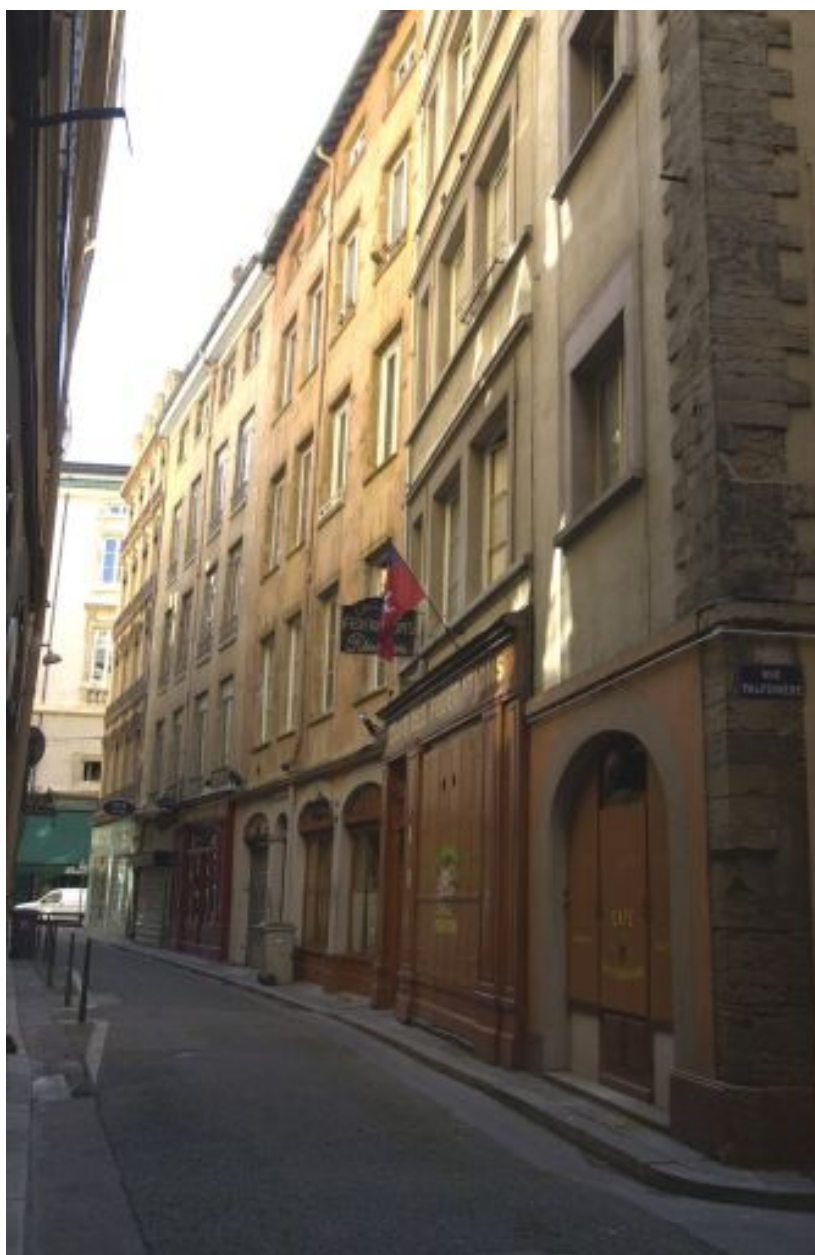
Vue générale dans la rue
