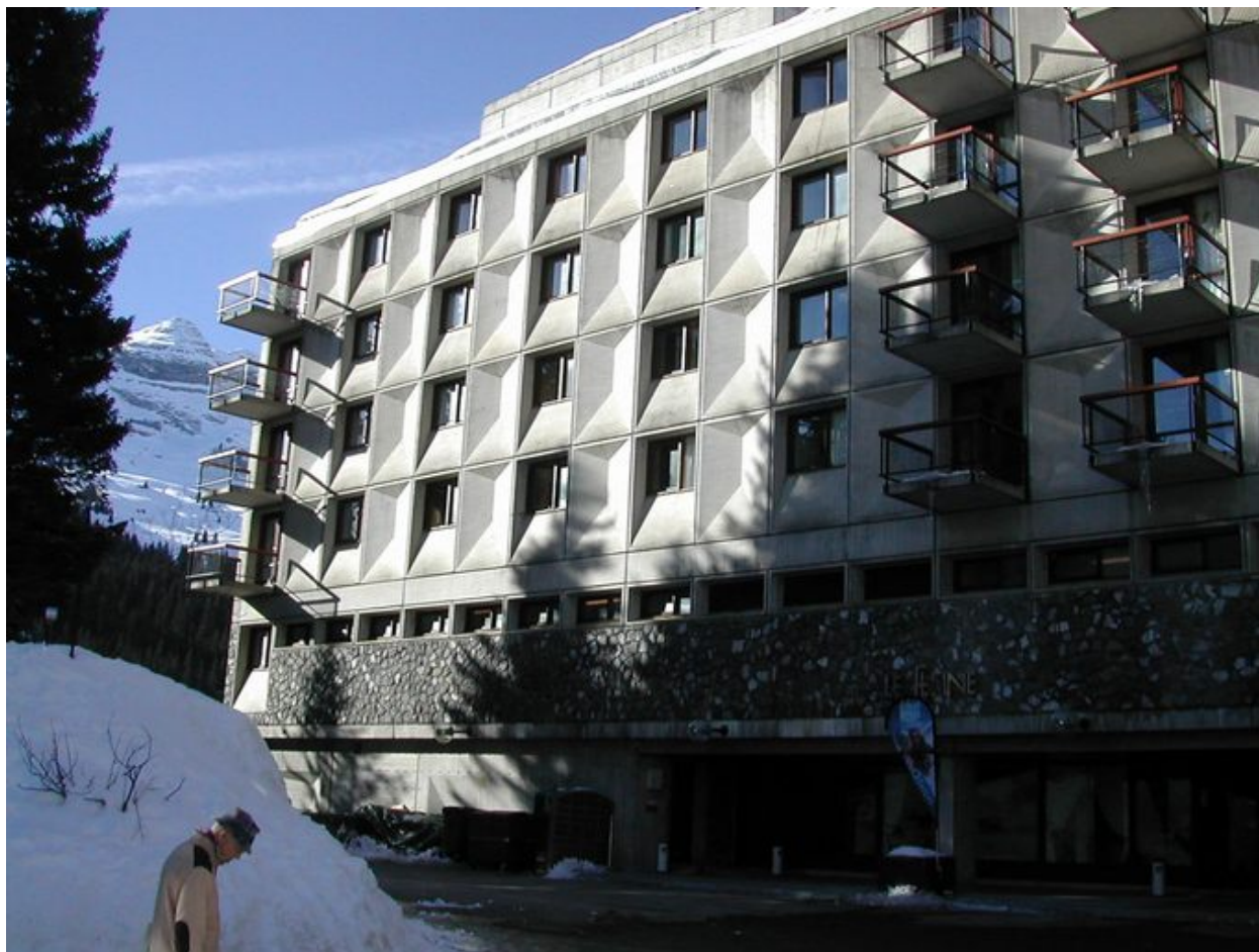
Elévation principale à l'est
