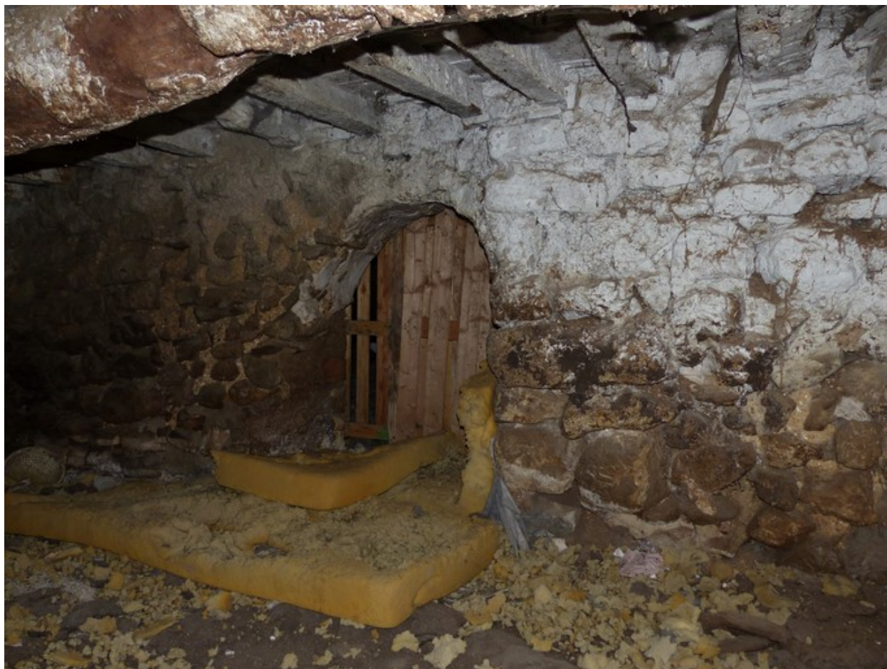
Partie ouest. Etage de soubassement, étable. Angle nord-est.
