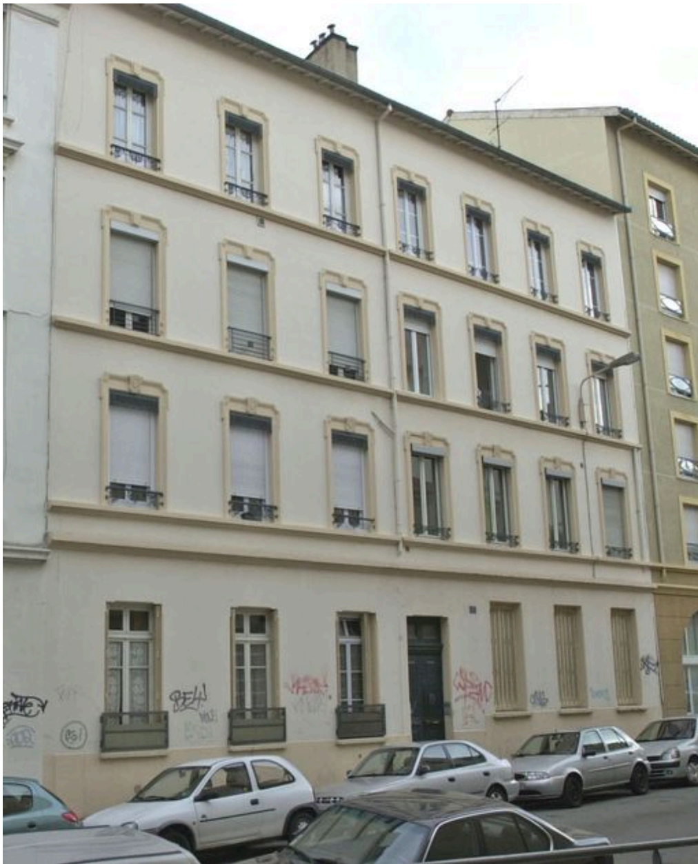
Façade sur la rue Béguin
