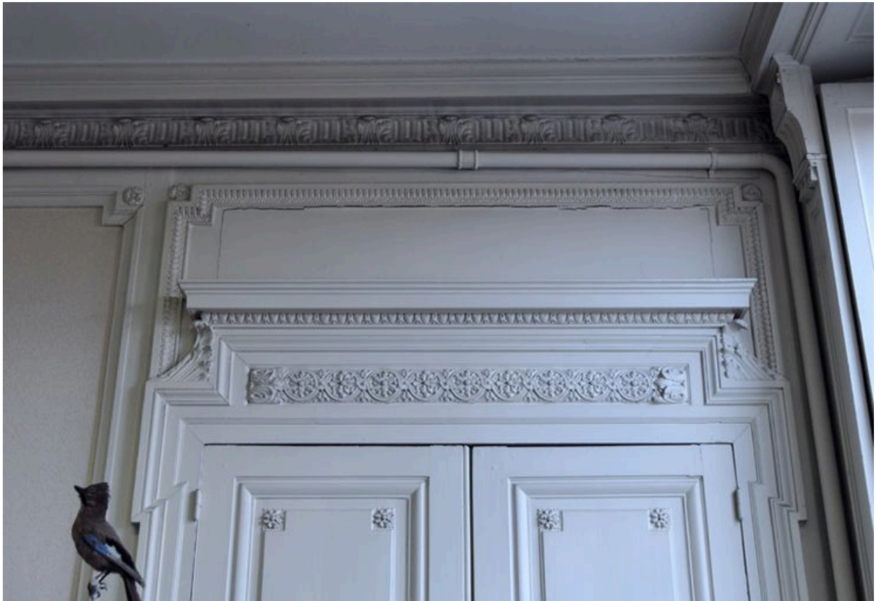
Appartement du 1er étage, pièce, actuel bureau du directeur de l'Institut de Chimie Industrielle, détail des boiseries
