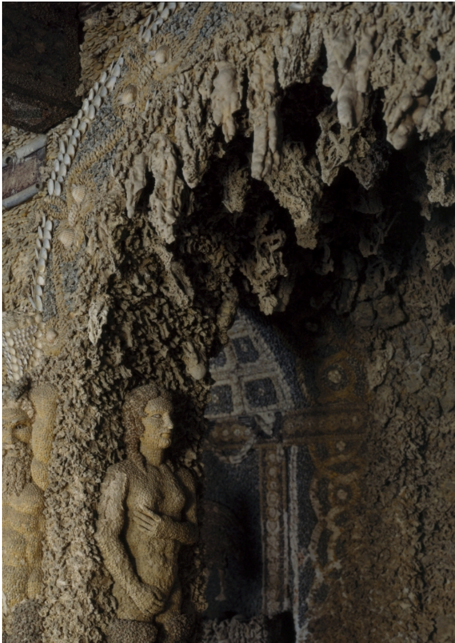
Mur sud, renforcement de droite : détail de rocailles et de concrétions.
