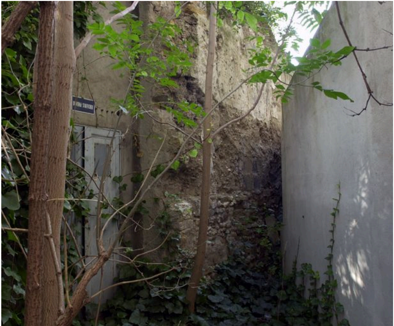
Cour, mur de clôture (mur nord) en pisé
