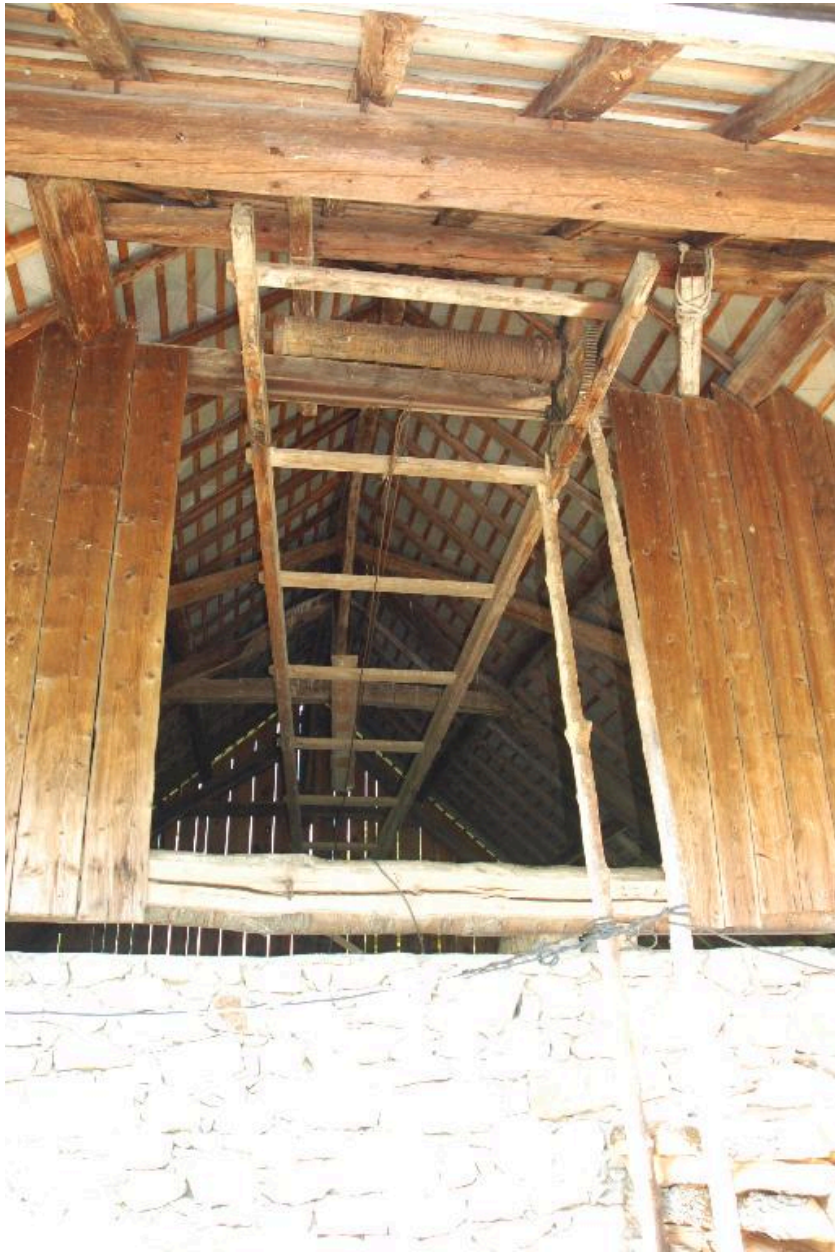
Vue de l'accès du fenil.
