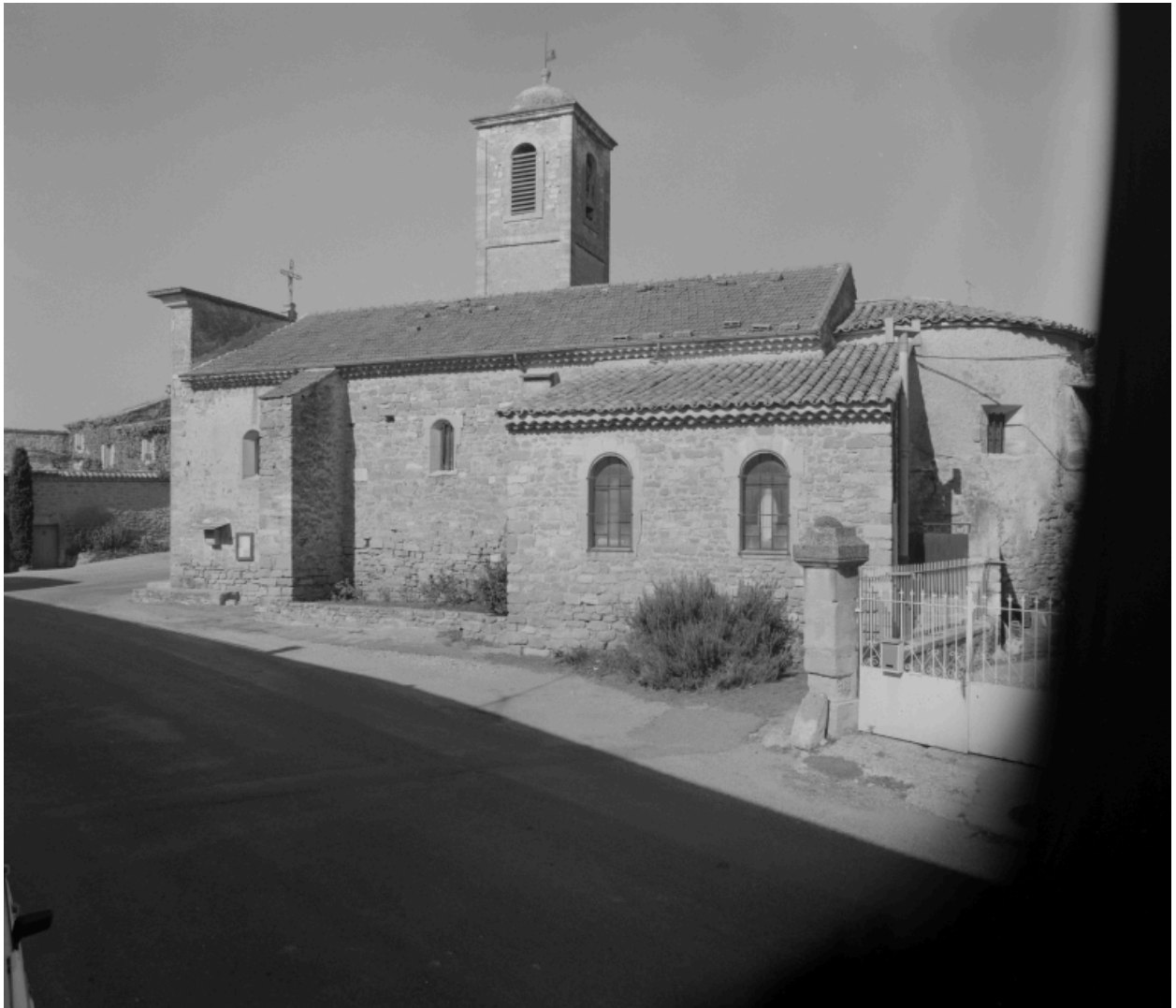
Vue d'ensemble, prise du sud (à droite, la sacristie).
