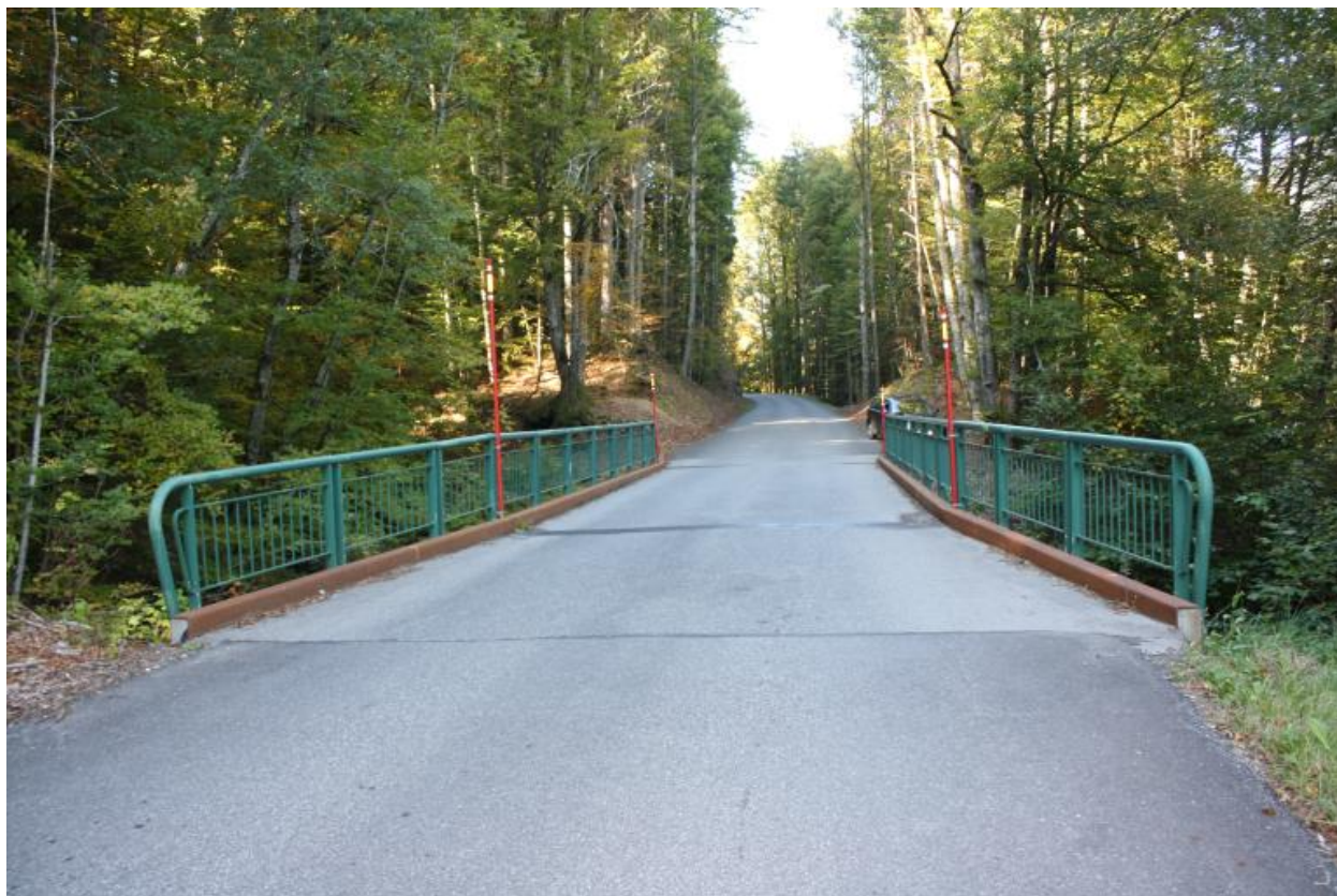
Le pont de la route de Montriond, contexte, chaussée et gardes corps
