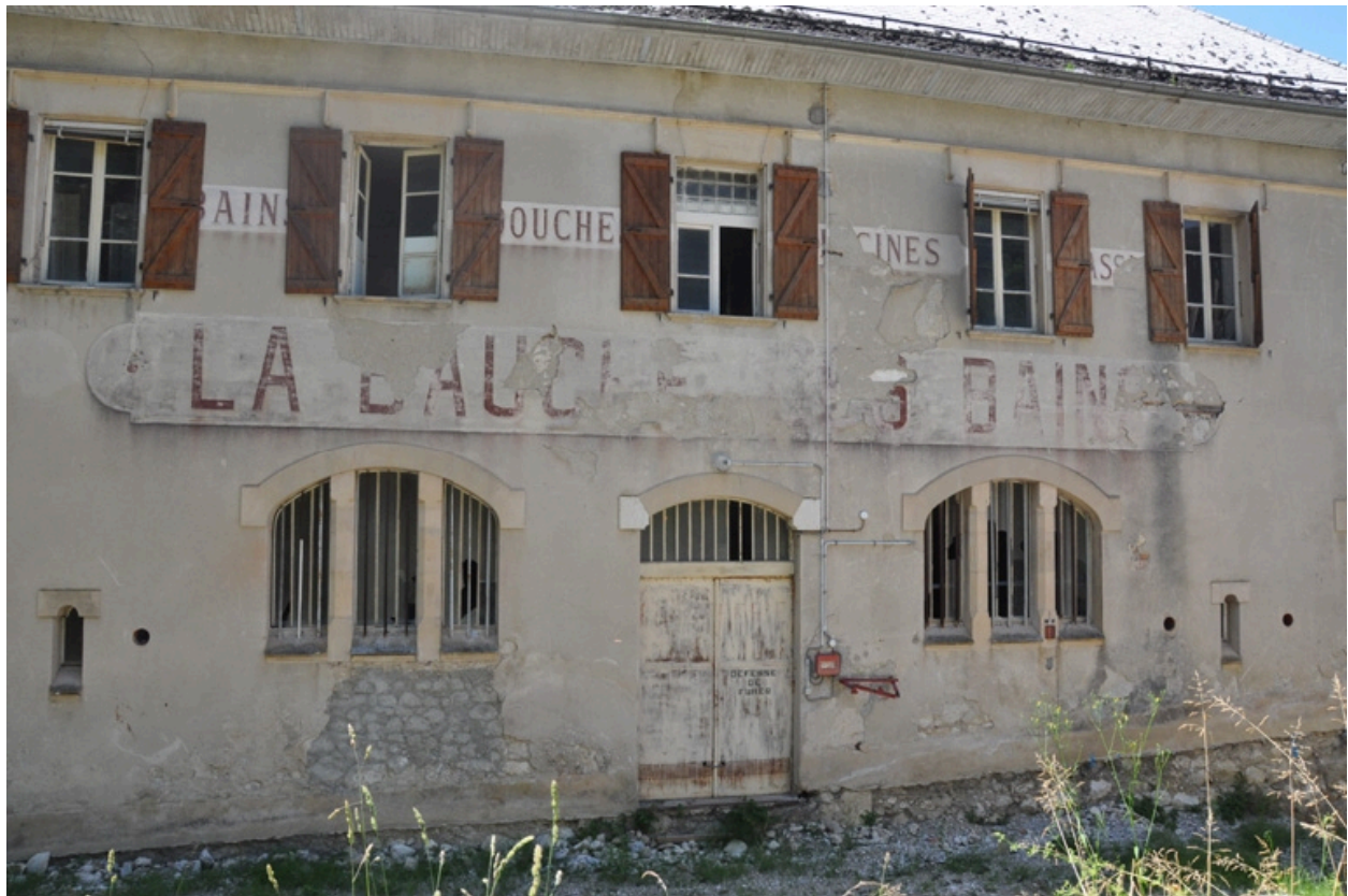
Détail de la façade est
