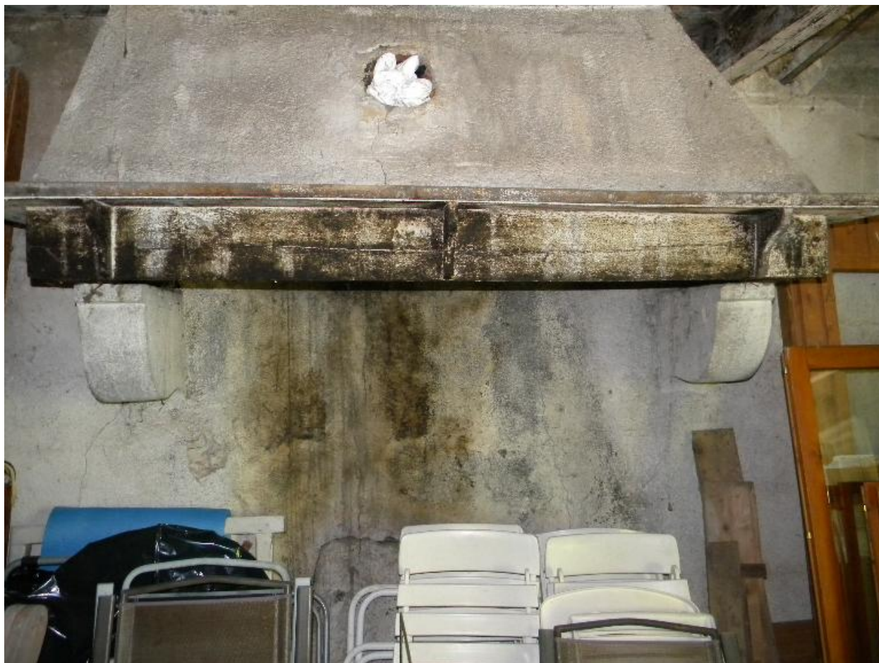
Vue de la cheminée dans la pièce principale.
