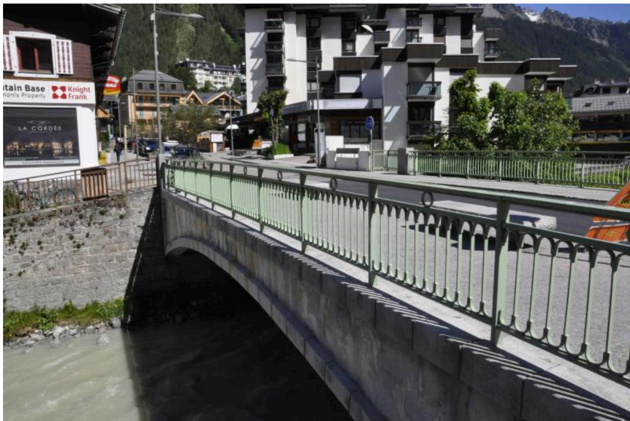
Vue de la face amont du pont
