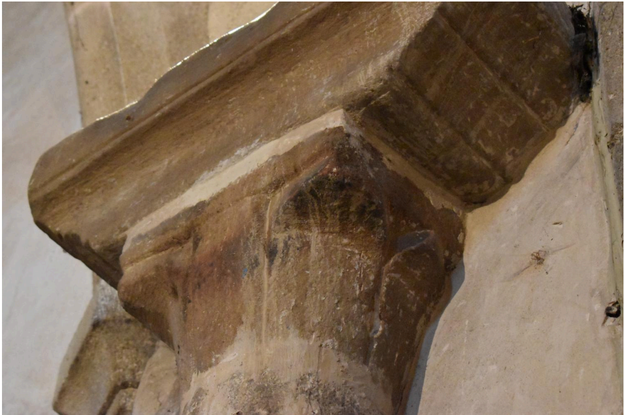
Chapiteau roman sculpté de feuilles d'eau à la retombée sud de l'arc doubleau brisé limitant la première travée et la seconde travée de la nef.
