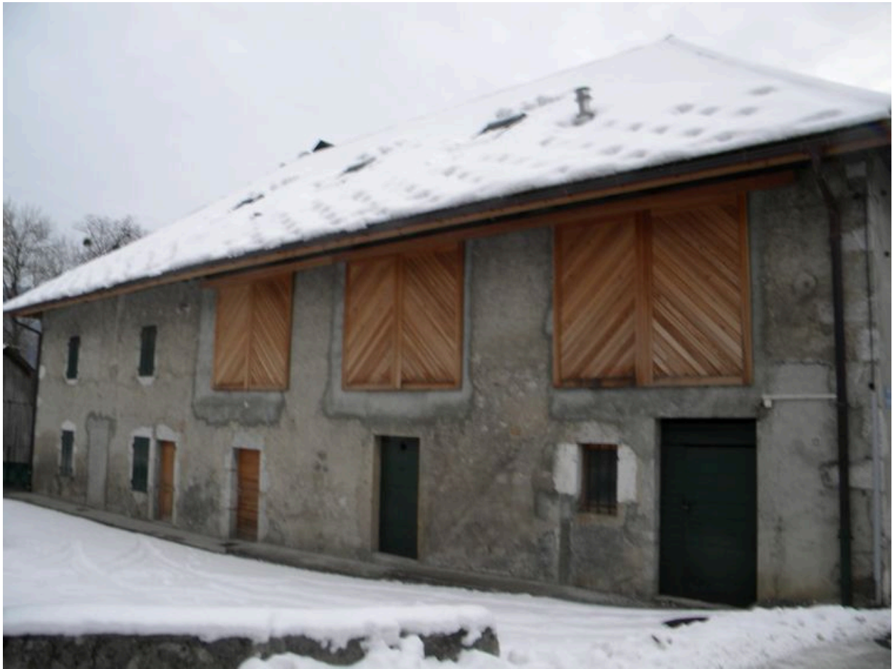
Vue intégrale de la façade nord-est.
